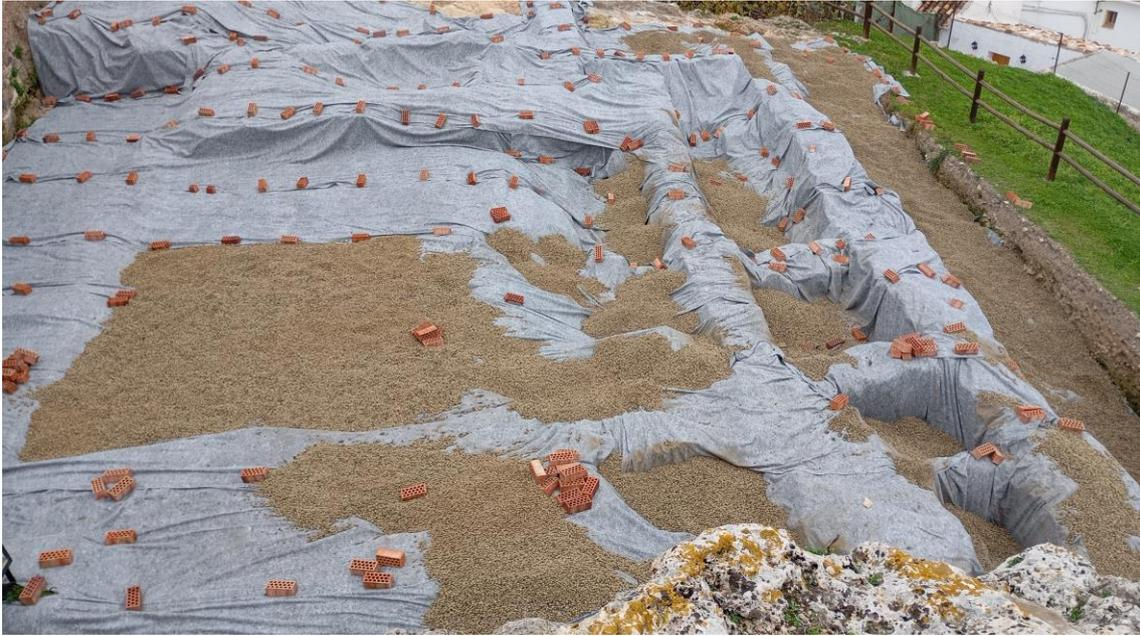
Primeros sacos de arlita extendidos sobre el geotextil
