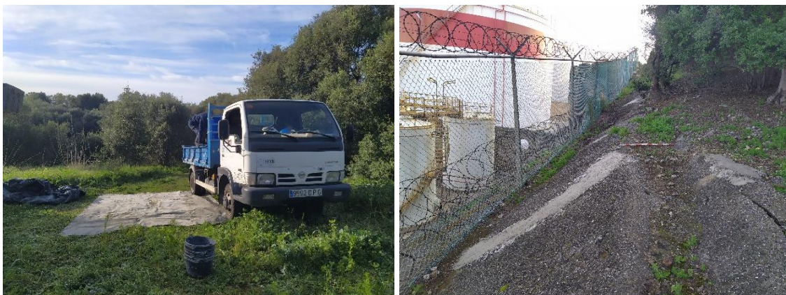
Trabajos sobre el yacimiento y resultado de la reparación en gunitado
