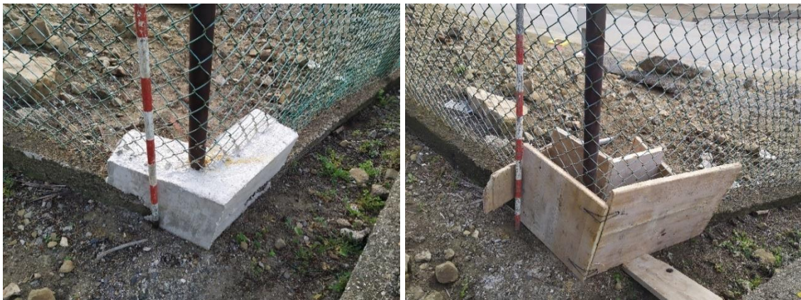
Reparación del Poste 2
