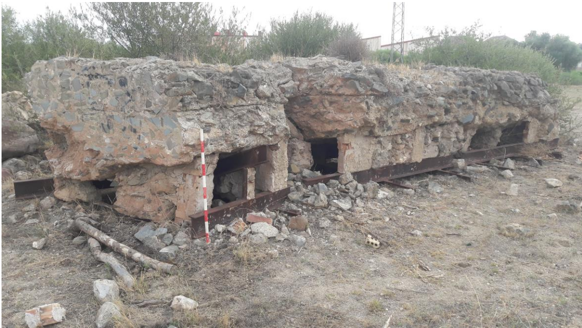
Estructura de mampostería en el Sector Norte
