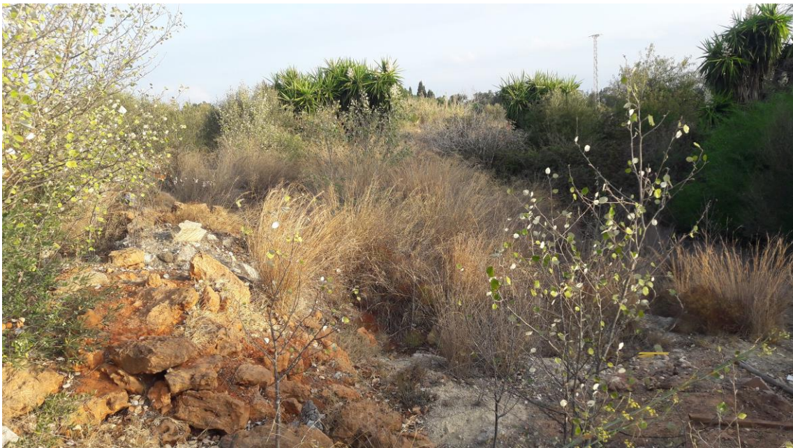
Escombros y vegetación del Sector Sur
