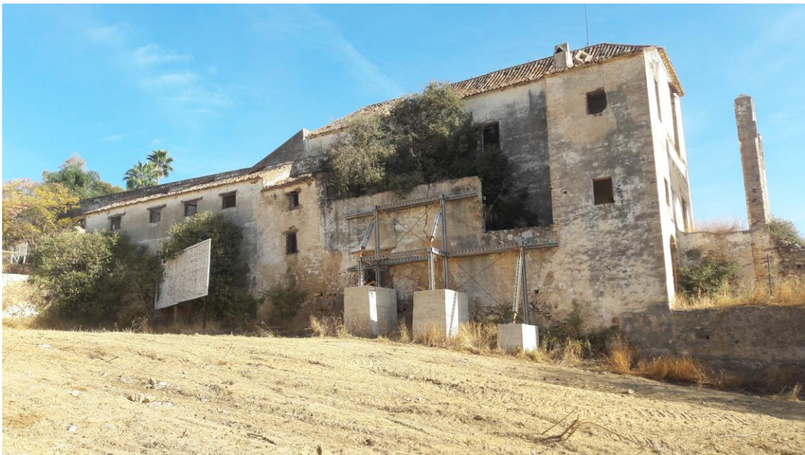
Edificio preindustrial desde el Oeste
