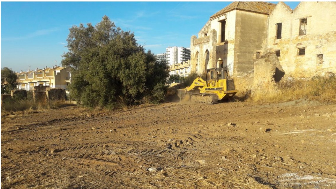
Vista general del sector Sur durante los trabajos de desbroce
