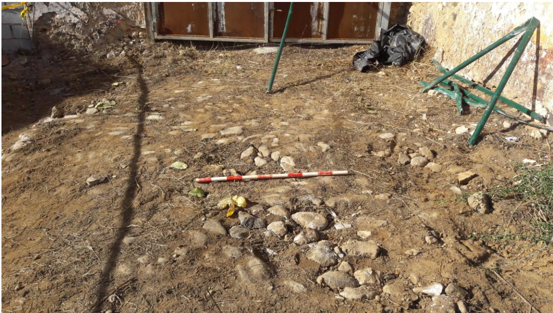
Pavimento original en la entrada (Norte)
