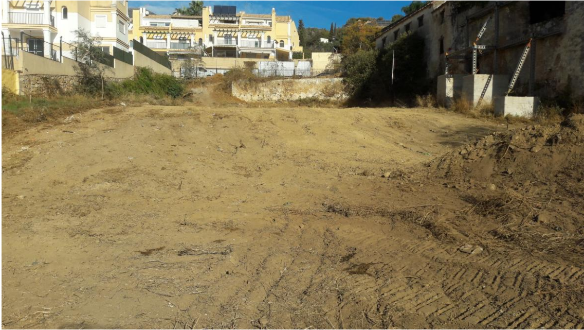
Sector Oeste tras el desbroce
