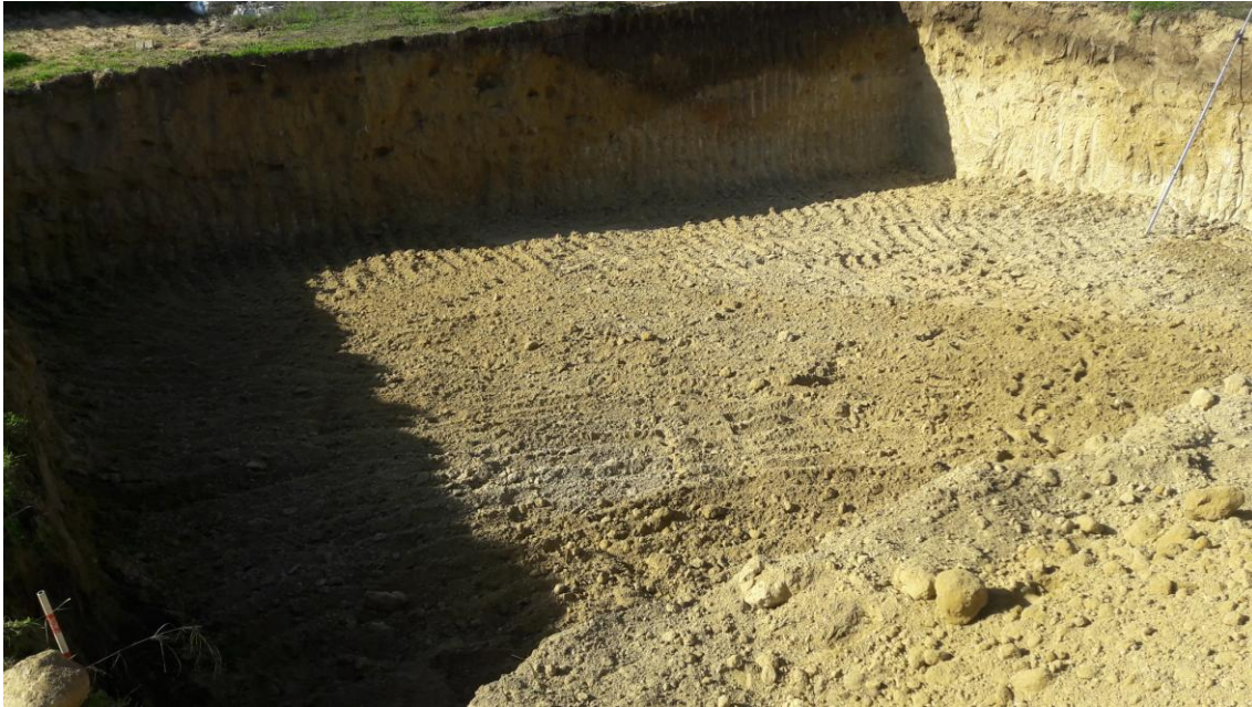
Vista final de la excavación
