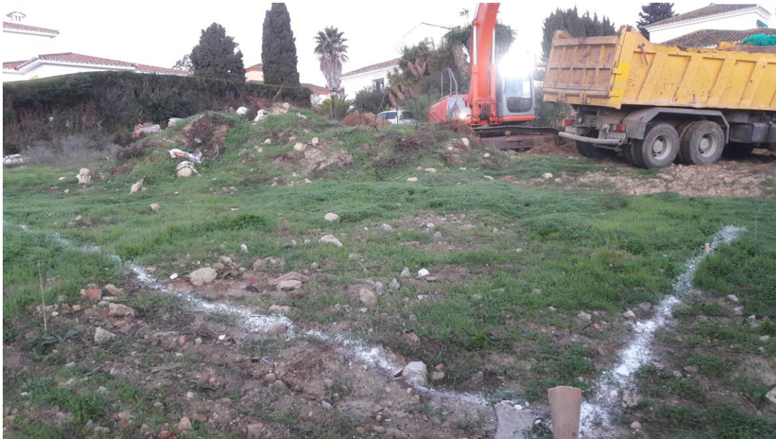
Parcela al inicio de los trabajos desde el Sur
