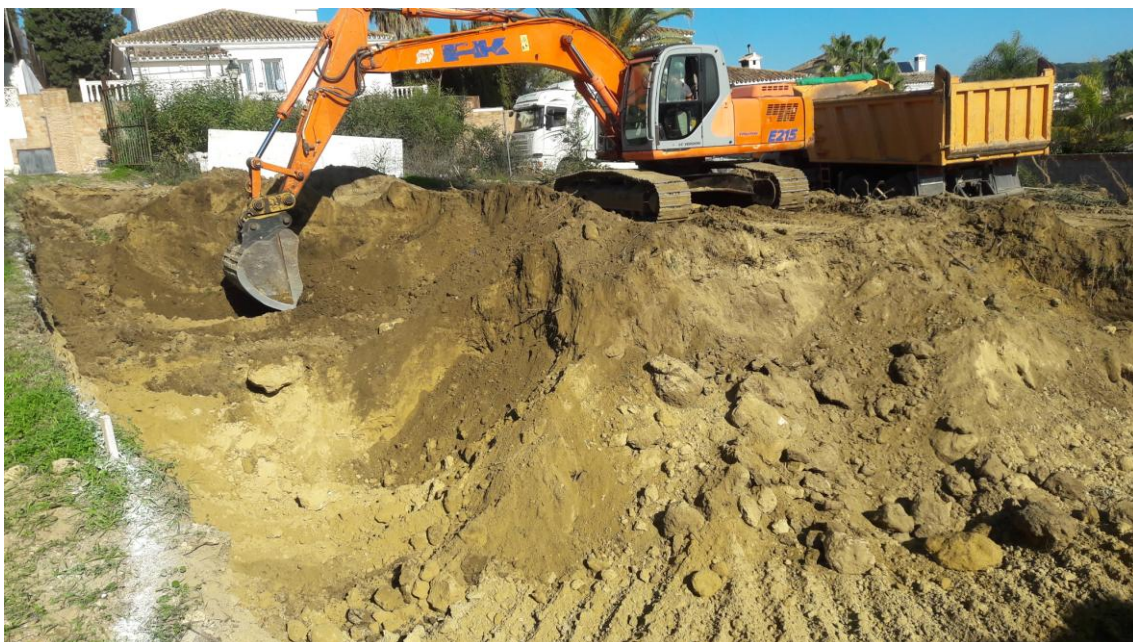
Proceso de excavación mecánica
