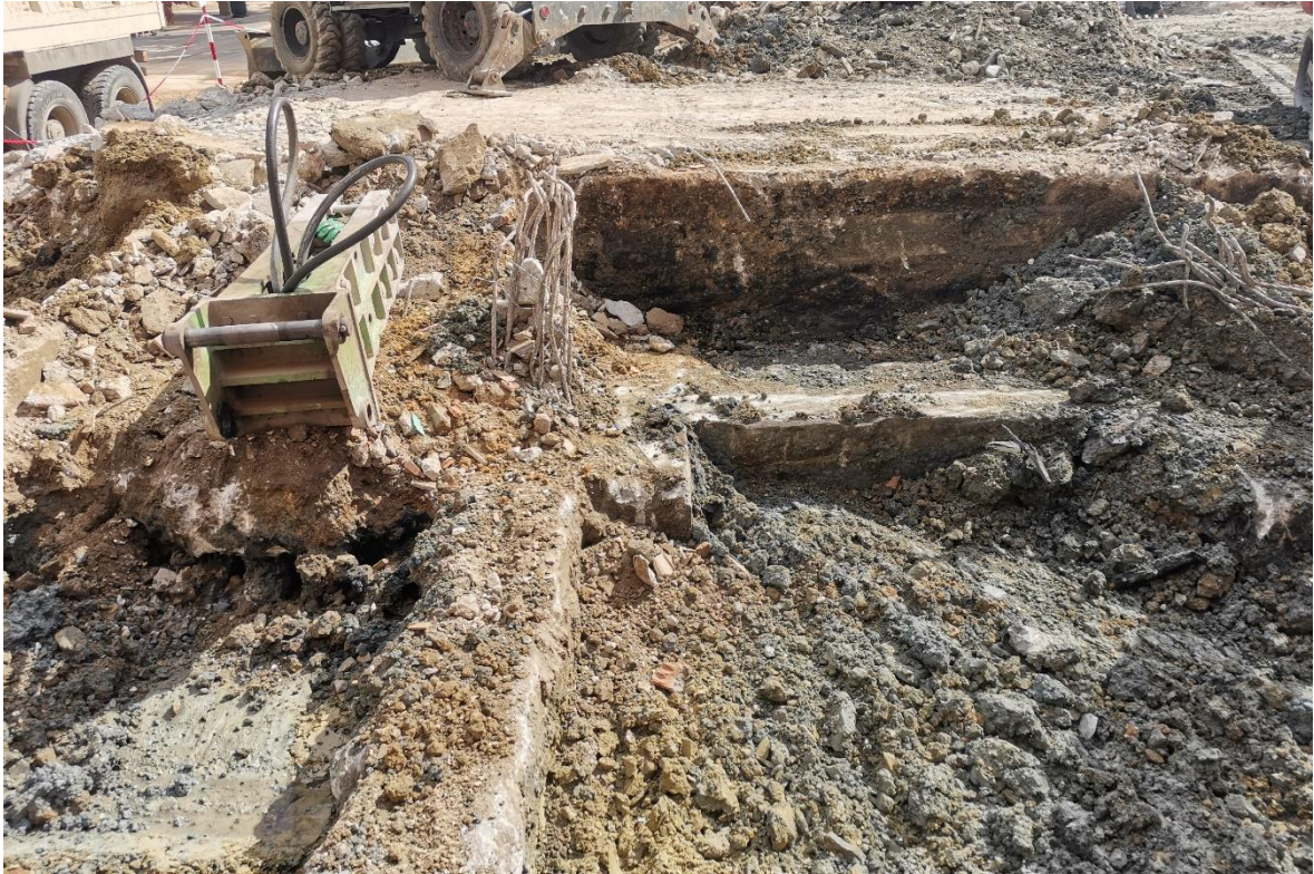
Lámina 5. Retirada de estructuras.
