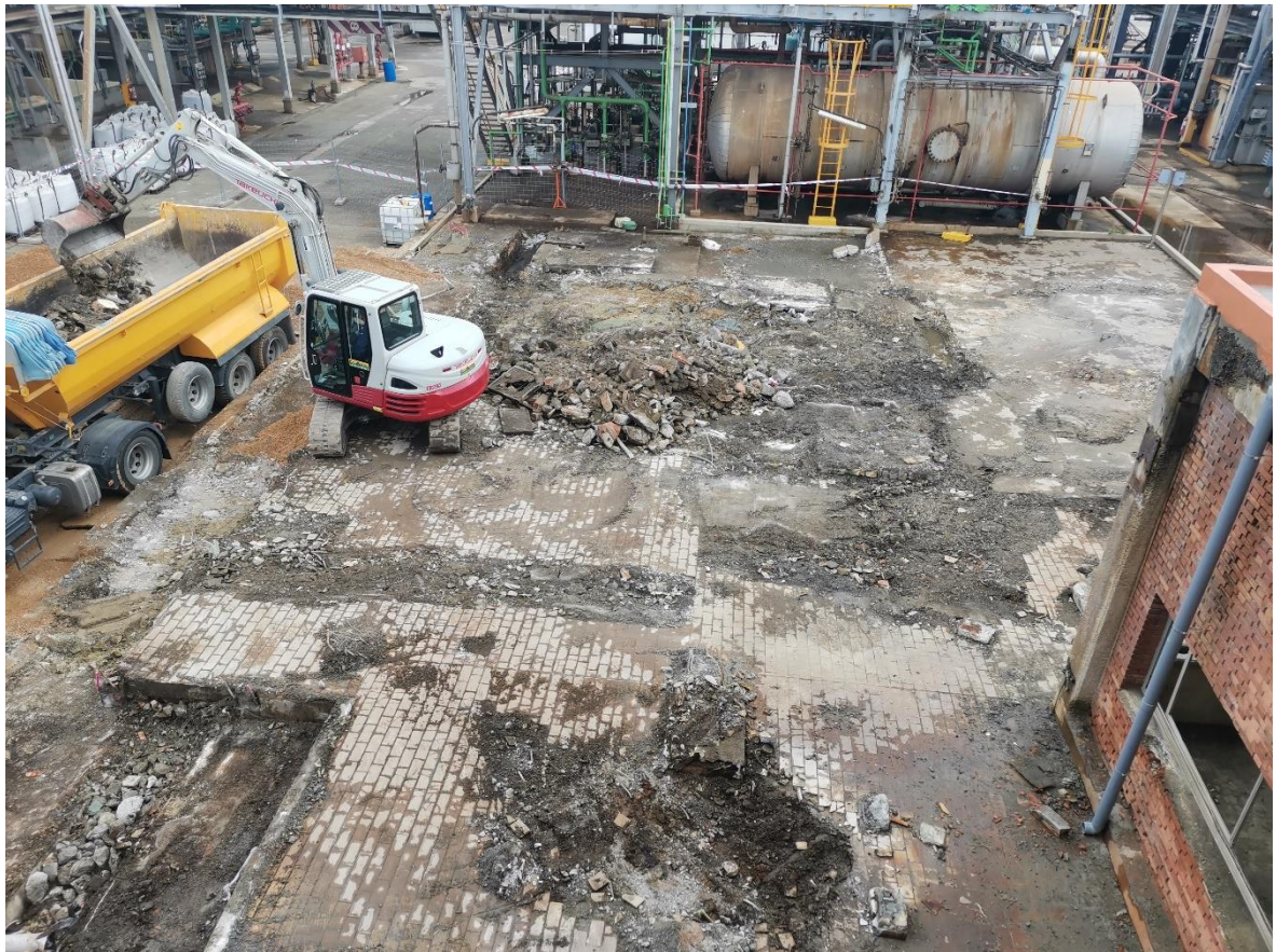
Lámina 1. Estado de la parcela al inicio de los trabajos.
