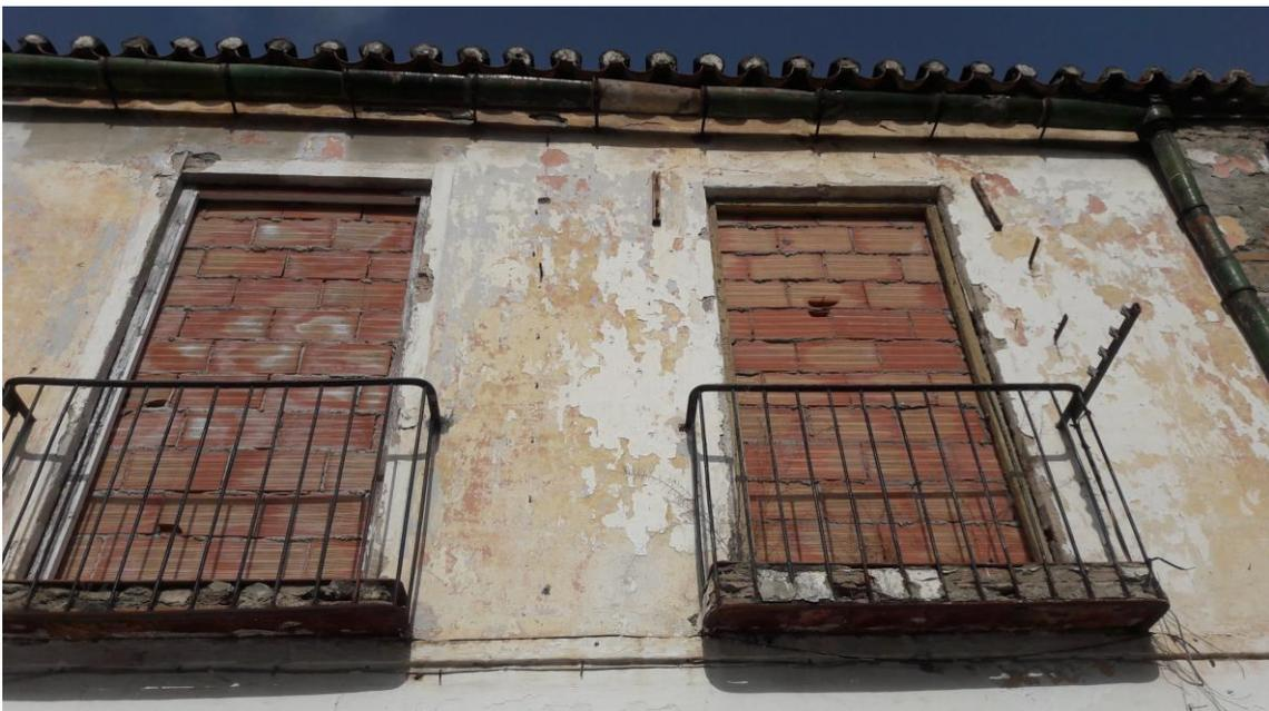
Lámina 17. Vista de la planta superior con las capas de cal descascarilladas
