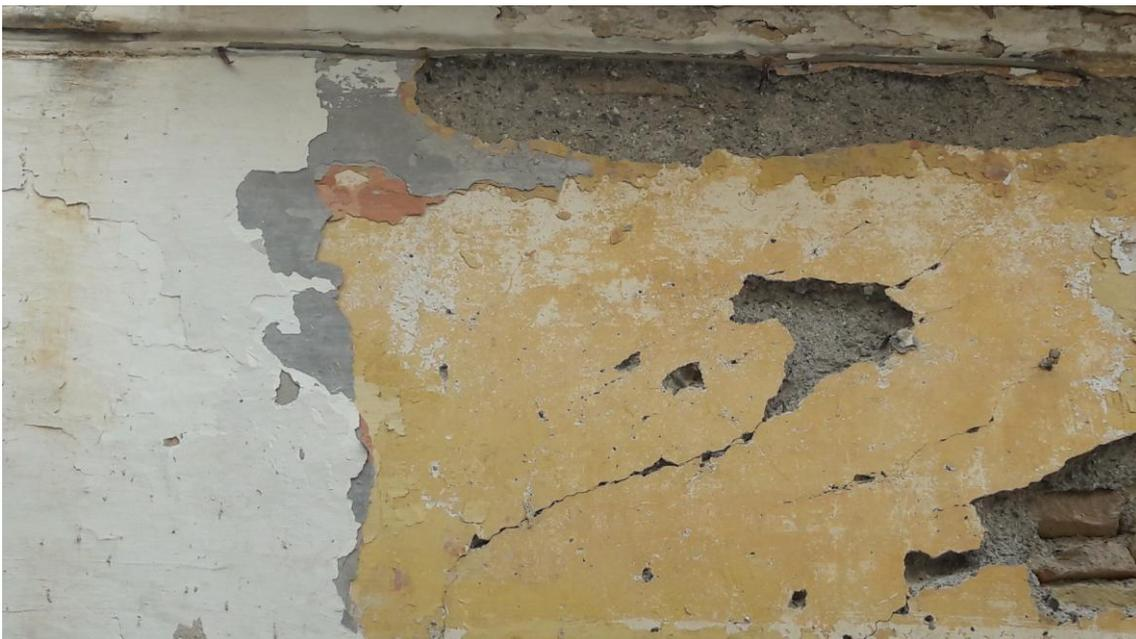
Lámina 19. Planta baja de la fachada con pérdida de enlucido y de capas de pintura
