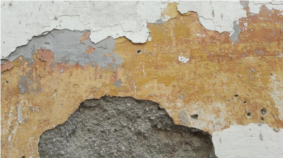
Lámina 7. Detalle de la superposición de capas de pintura en la fachada
