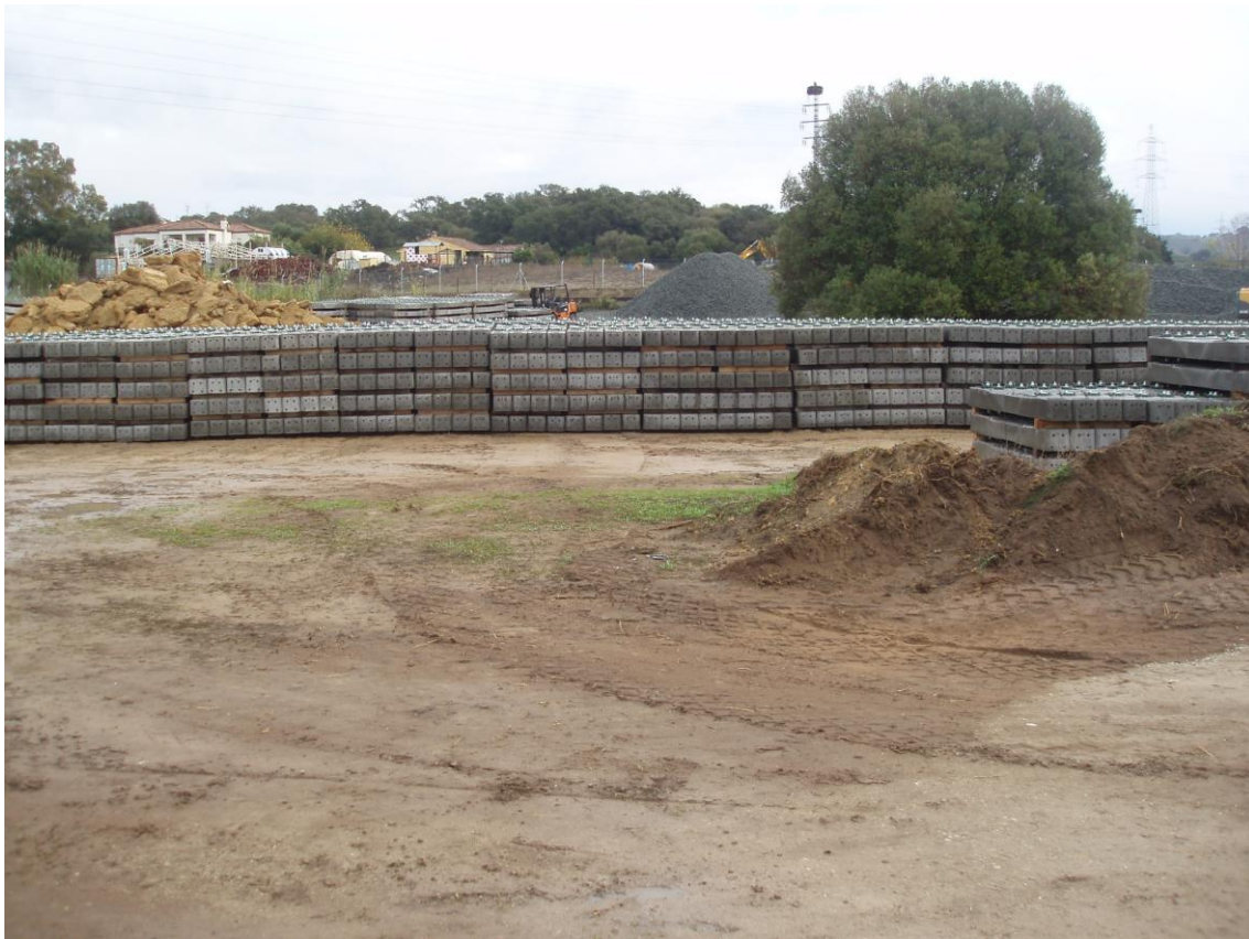
Lámina 15. Vista de la parcela con el acopio de traviesas
