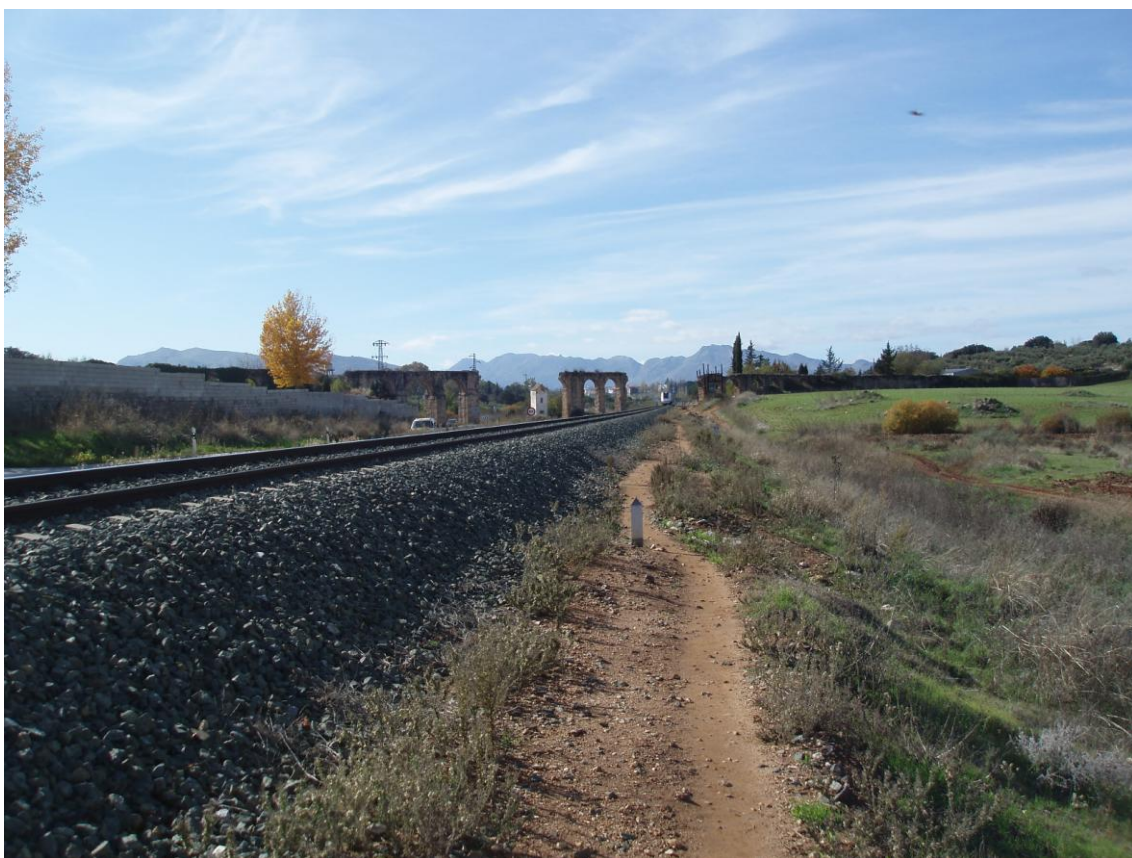
Lámina 8. Vista desde la parcela del acueducto existente
