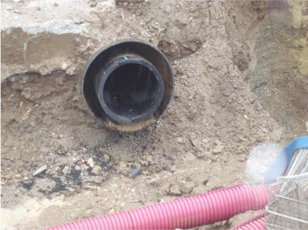
Lámina 5. Tubería de pvc dentro del tubo metálico de la hinca
