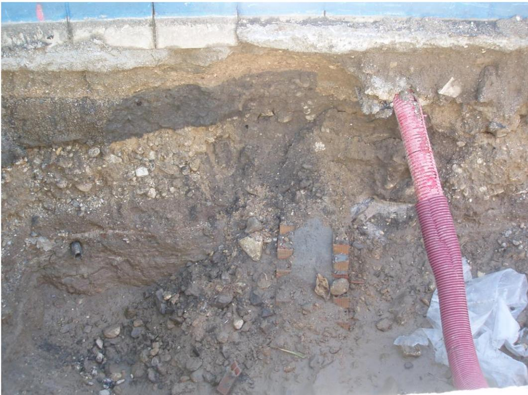
Lámina 2. Perfil estratigráfico del sondeo
