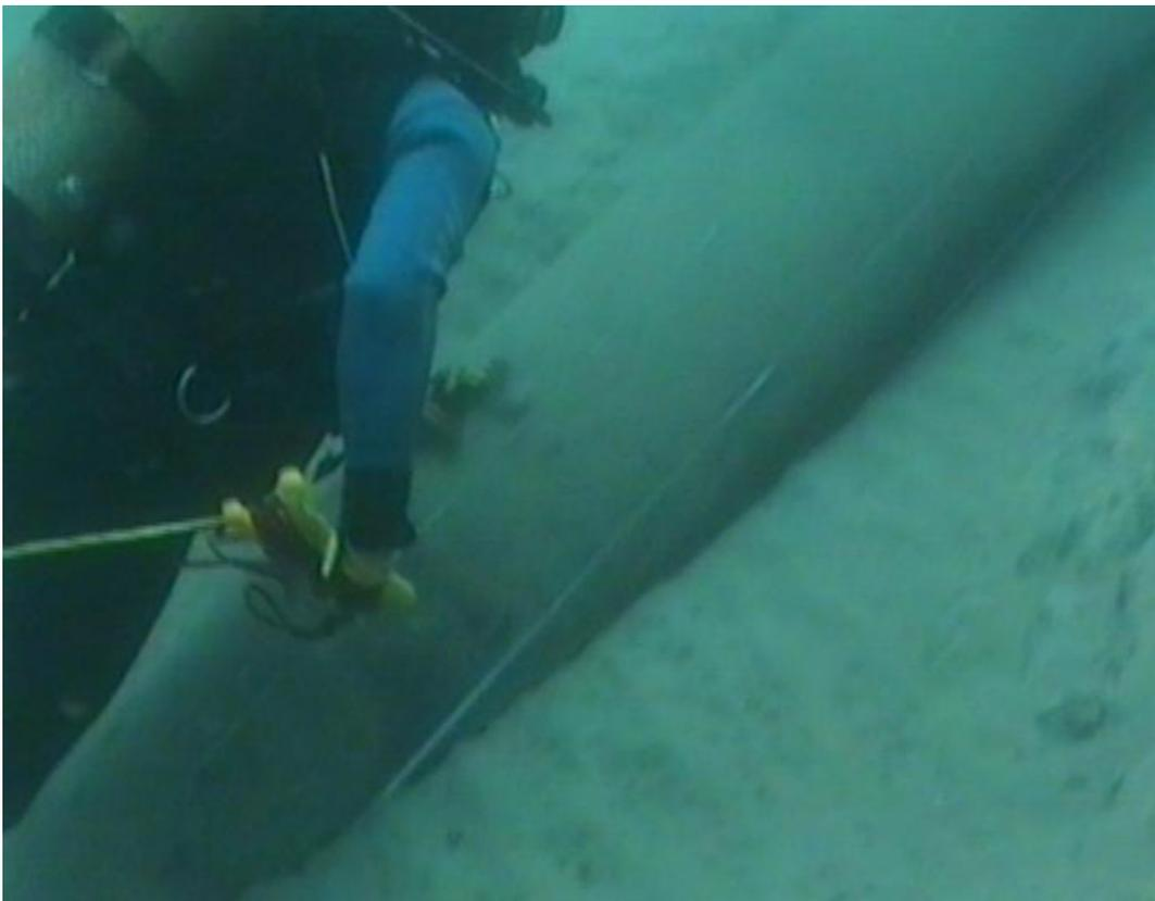
Lámina 9. Ensamble de la hınca con el primer tubo depositado en el fondo marino
