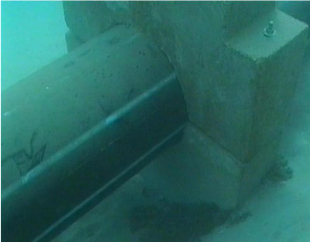
Lámina 10. Brida de hormigón que sirve como lastre y unión de los tubos
