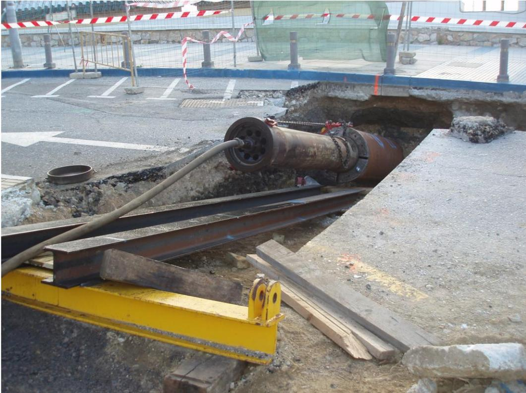
Lámina 3. Equipo de perforación de la hinca
