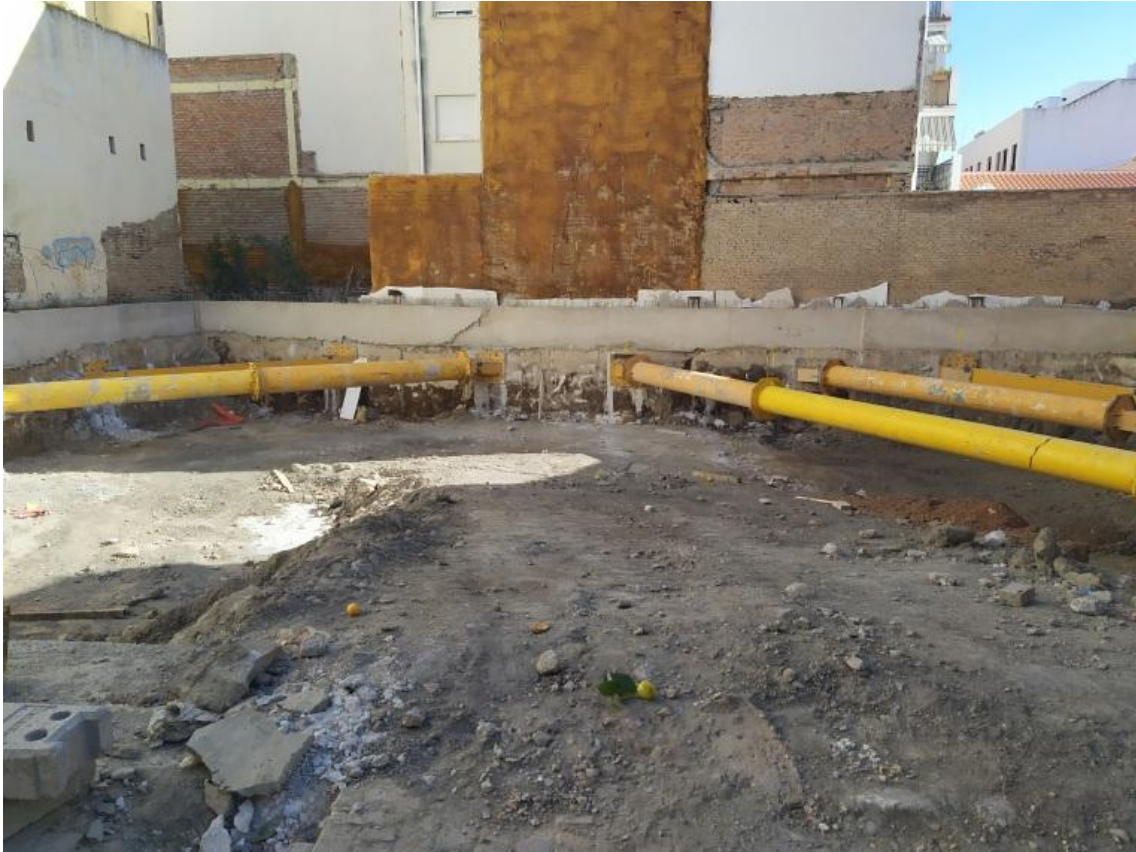
Lámina 3. Vista del solar tras la colocación de las medidas de seguridad
