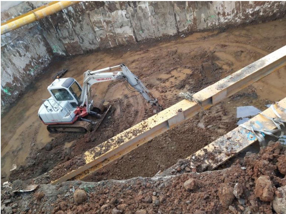
Lámina 4. Imagen de la excavación afectada por el nivel freático
