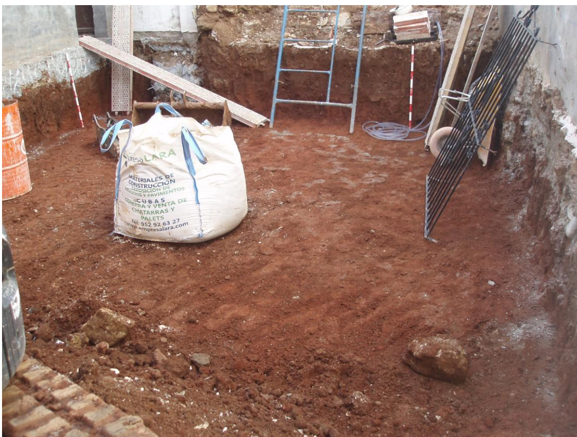
Lámina 1. Vista final del solar.
