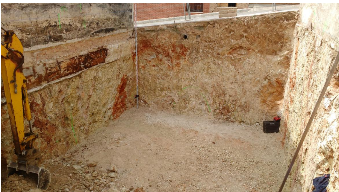
Lámina 2. Final de excavación del primer batache.
