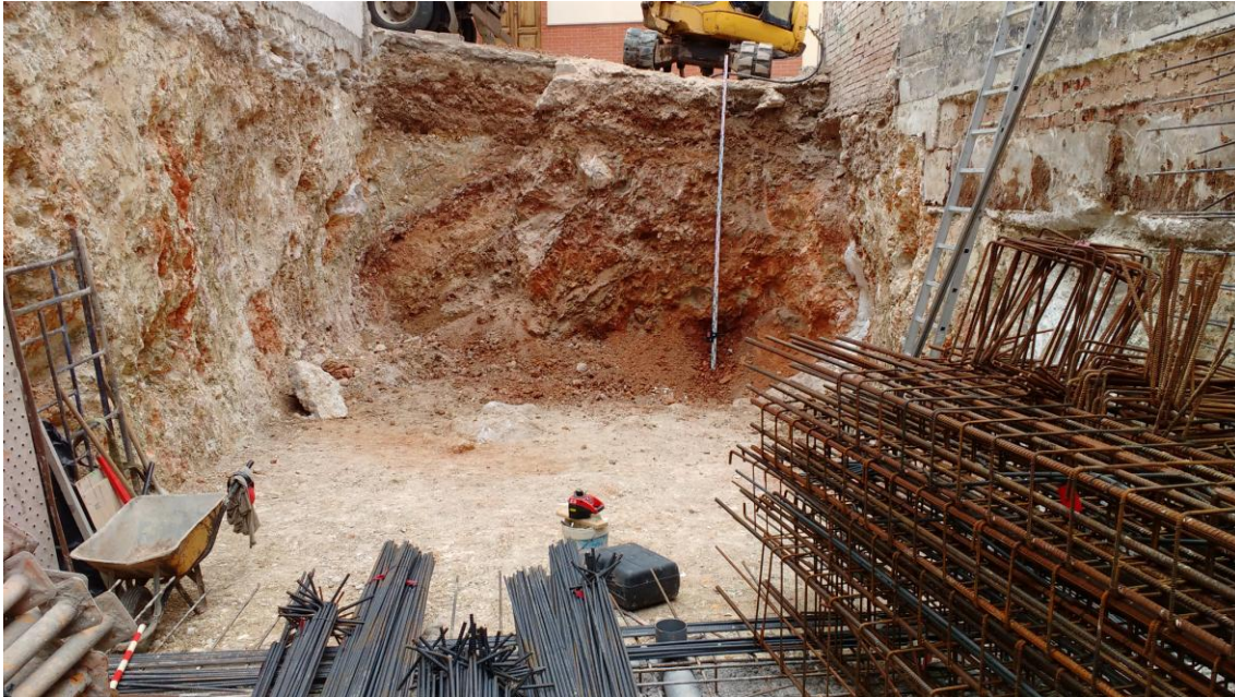
Lámina 3. Vista final de la excavación del segundo batache.
