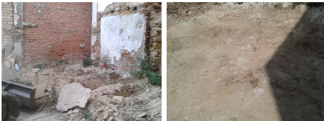
Imagen del solar antes y después del rebaje mecánico.
