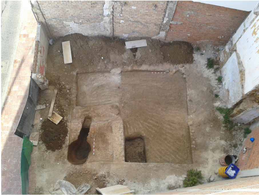
Vista aérea de la planta final de excavación.
