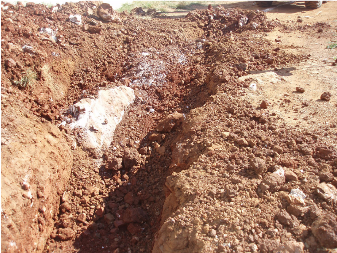
Lámina 2. Vista de la zanja con afloramiento de la roca natural.
