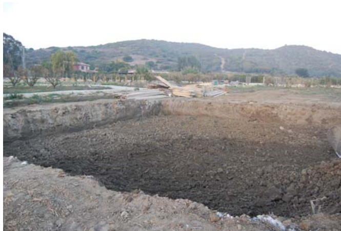
Vista del área de trabajo.
