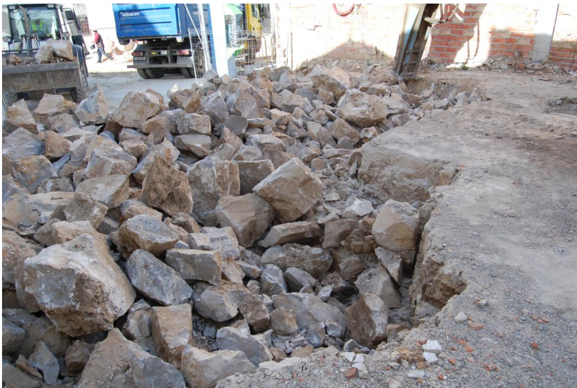
Lámina 1. Vista de la roca del solar durante el rebaje mecánico.
