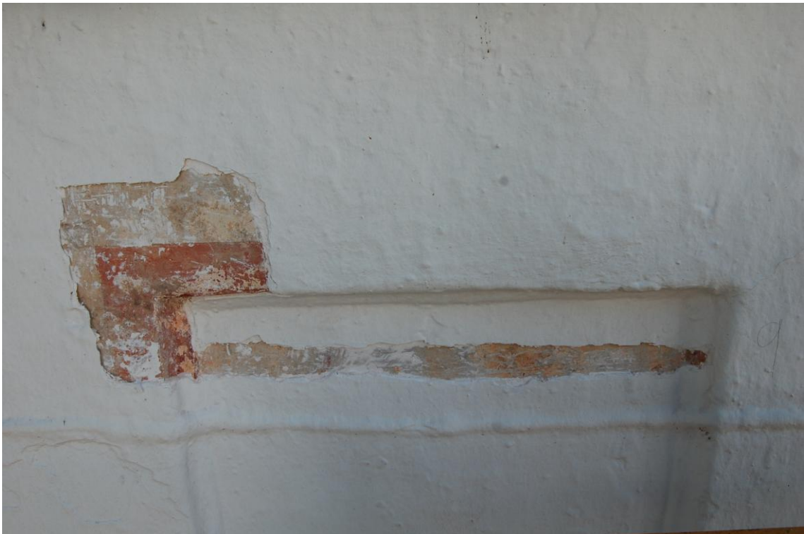
Lámina 4. Detalle de los restos de pintura.
