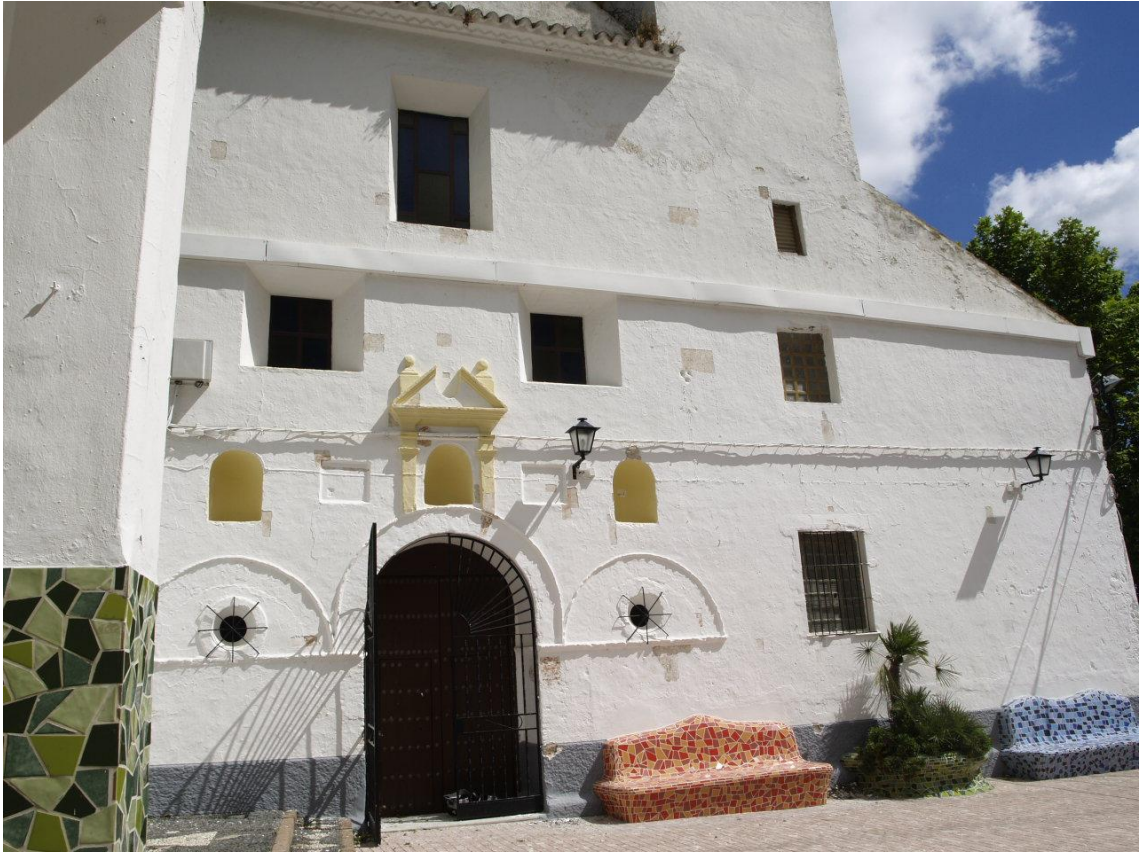
Lámina 1. Vista general de la fachada.
